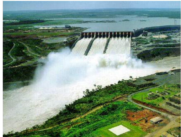
Gambar 4.9 Pembangkit Listrik Tenaga Air, atau PLTA. (Sumber: energitoday.com )
